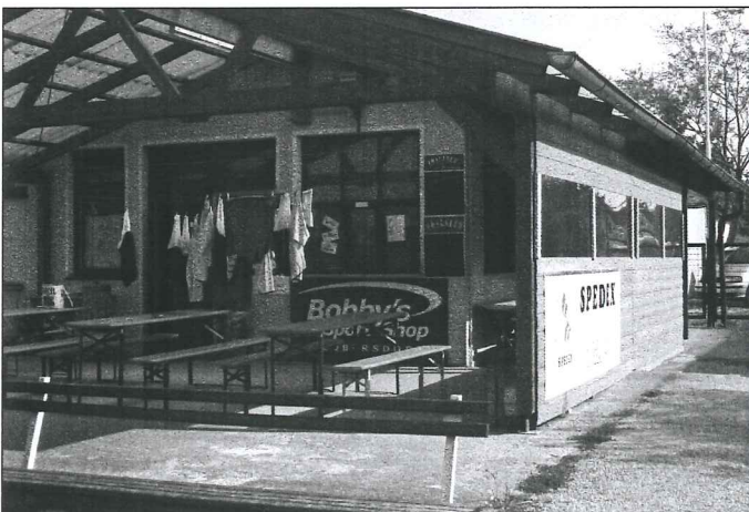
Die Kantine des SV Sooß wird ausgebaut
