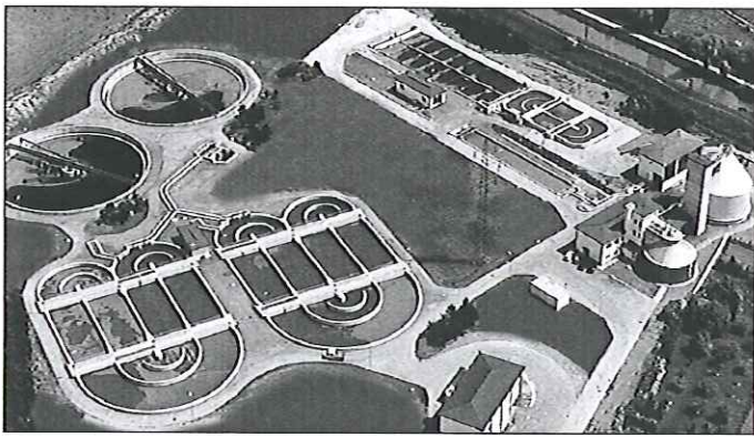
Die Kläranlage Bad Vöslau soll in Zukunft das Sooßer Abwasser aufnehmen.
