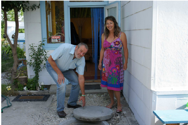
gfGR Franz Waldhäusl mit Frau Katarina Weiss bei der Abnahme des neuen Kanalanschlusses
